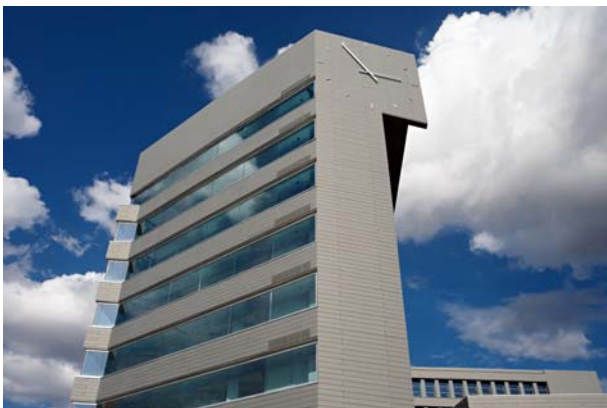
Foto 3: Edificio de la Junta de Andalucía (Granada)
