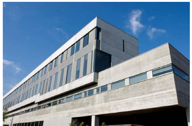
Foto 7: Facultad CCEE (La Coruña)
