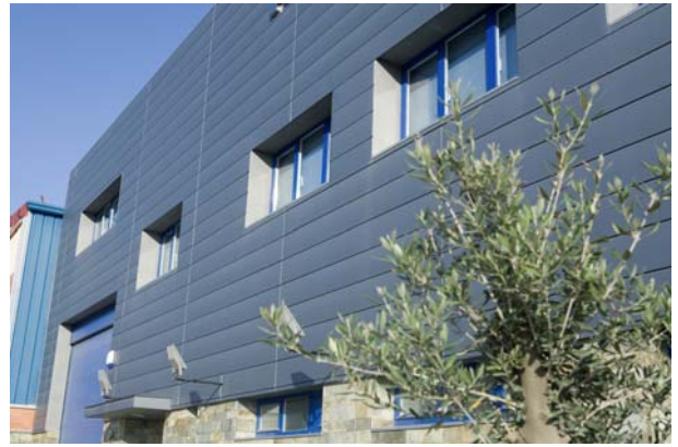
Foto 5: Nave Industrial La Cistérniga (Valladolid)
