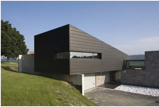
Foto 1: Casa unifamiliar en Mungia (Vizcaya)
